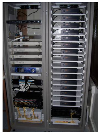
เครื่องควบคุมระบบและ ตู้ Rack ใสอุปกรณ์
