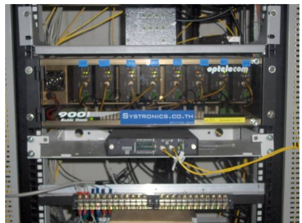
อุปกรณ์แปลงสัญญาณ ไฟเบอร์ออฟติก
