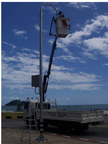
ตรวจเช็คการทำงานและทำความสะอาดกล้องฯ บริเวณริมหาดชลาทัศน์ เทศบาลนครสงขลา
